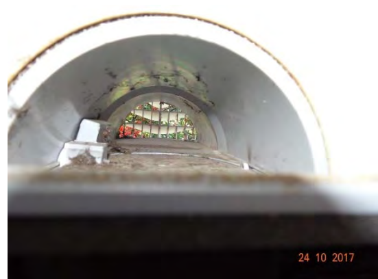
Abbildung 75: WNG ID 320: FOL-Kanal ab Gerät
