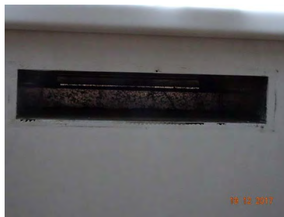
Abbildung 97: WNG ID 420: Durchbruch AUL-Eintritt
