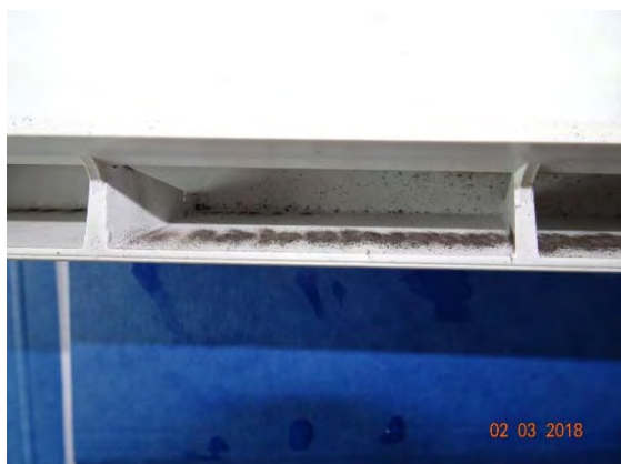
Abbildung 167: WNG ID 730: Ablagerung an ZUL-El.
