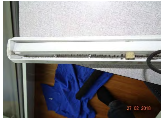
Abbildung 148: WNG ID 710: Ablagerung an ZUL-El.
