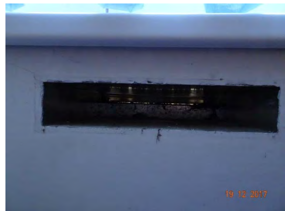
Abbildung 86: WNG ID 410: Durchbruch AUL-Eintritt
