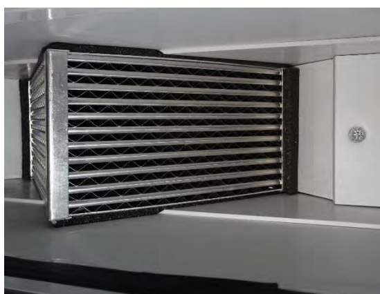
Abbildung 131: WNG ID 610: Wärmetauscher
