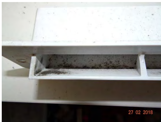
Abbildung 156: WNG ID 720: Ablagerung an ZUL-El.
