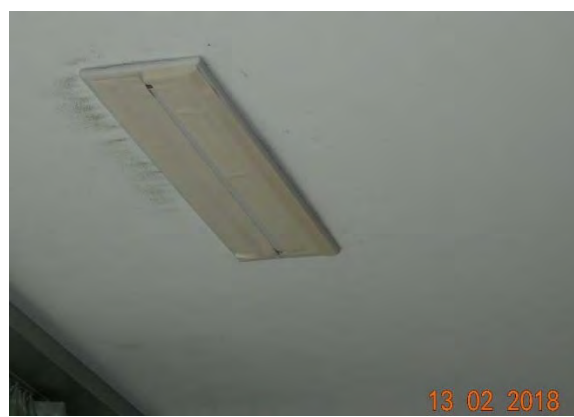
Abbildung 115: WNG ID 520: AUL-Eintritt, abgeklebt
