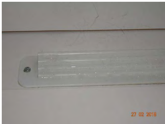
Abbildung 154: WNG ID 720: Kondensat an ZUL-El.
