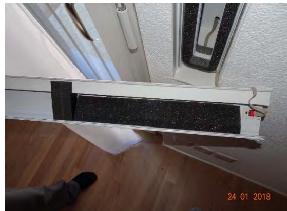
Abbildung 128: WNG ID 610: Luftführungselemente
