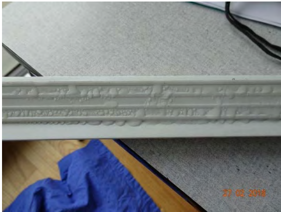
Abbildung 145: WNG ID 710: Kondensat an ZUL-El.
