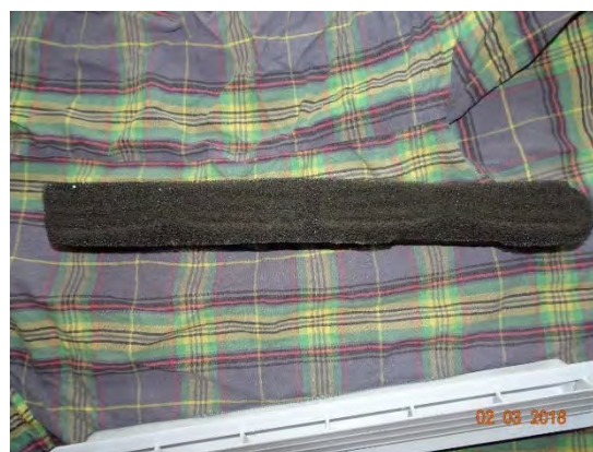
Abbildung 175: WNG ID 730: Zuluftfilter
