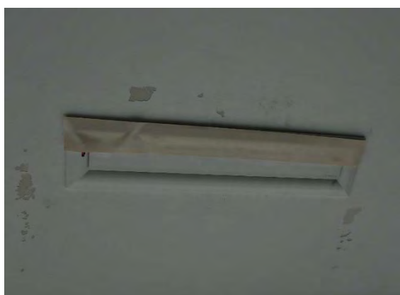
Abbildung 114: WNG ID 520: AUL-Eintritt, abgeklebt
