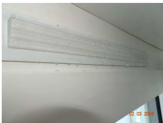
Abbildung 165: WNG ID 730: Kondensat an ZUL-El.
