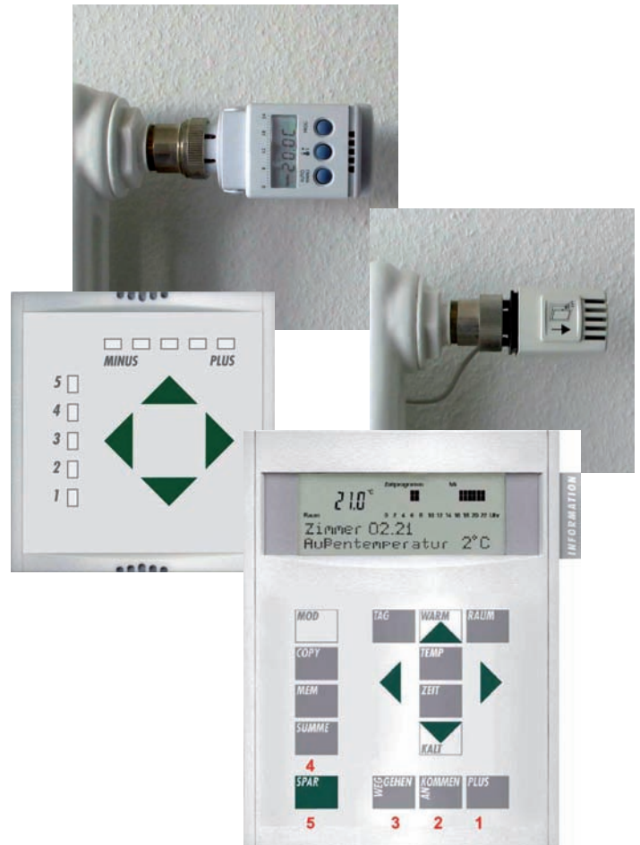
Zeitgesteuerte Heizkörperregler und Regelungseinheiten für die Einzelraumregelung. Quelle: Görres et al: Kohlendioxid-Emissionsreduktion im Altenzentrum Sonnenberg, Abschlussbericht, 2007.
