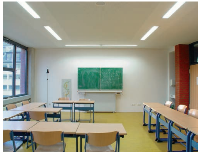
Beleuchtung eines Klassenraumes mit Langfeld-Rasterleuchten. Quelle: licht.de.
