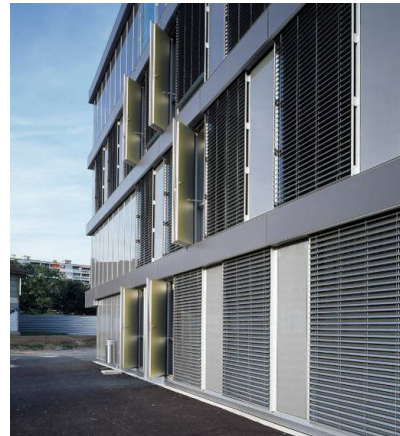
Abbildung 5: Ein Objekt mit ähnlichen Lüftungsflügeln, hingegen nach Aussen öffnend wurde in Genf gebaut (Cycle d'orientation Cayla, Foto: Susanna Fritscher)
