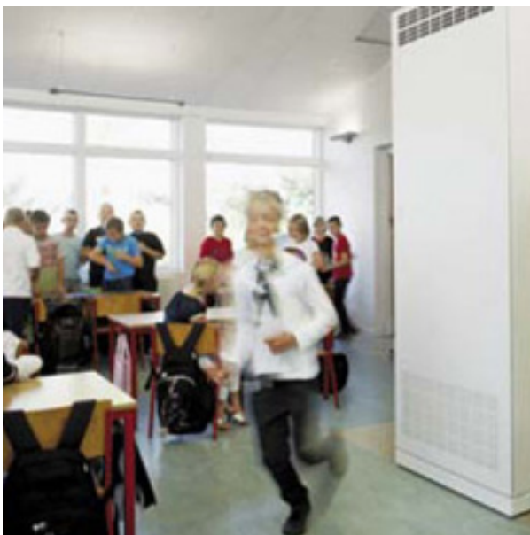
Abbildung 10: Lüftungsschrank (Quelle: Energenio AG)
