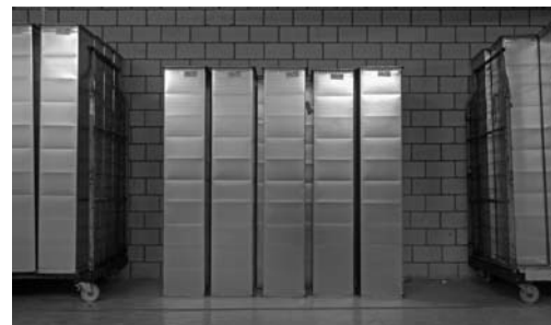
Gaines d'air avant leur installation, entreposées de manière propre et ordonnée.
