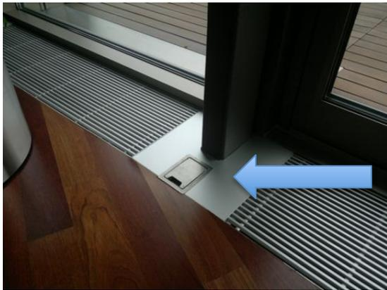
Bei einem Bürogebäude in Stahl und Glas mit Parkettfußboden von 1500 m<sup>2</sup> Fläche und 50 Mitarbeitern hat sich der Reinigungsaufwand um 30% bis 40% reduziert. Der Schlauch wird einfach in die Dose eingesteckt. Gesucht werden diese Anlagen vermehrt für sensible Bewohner, z.B. in Alters- und Pflegeheimen. Deren Anlage ist im „Keller“ und braucht nur ca. alle 6 Monate einen Filterwechsel.
