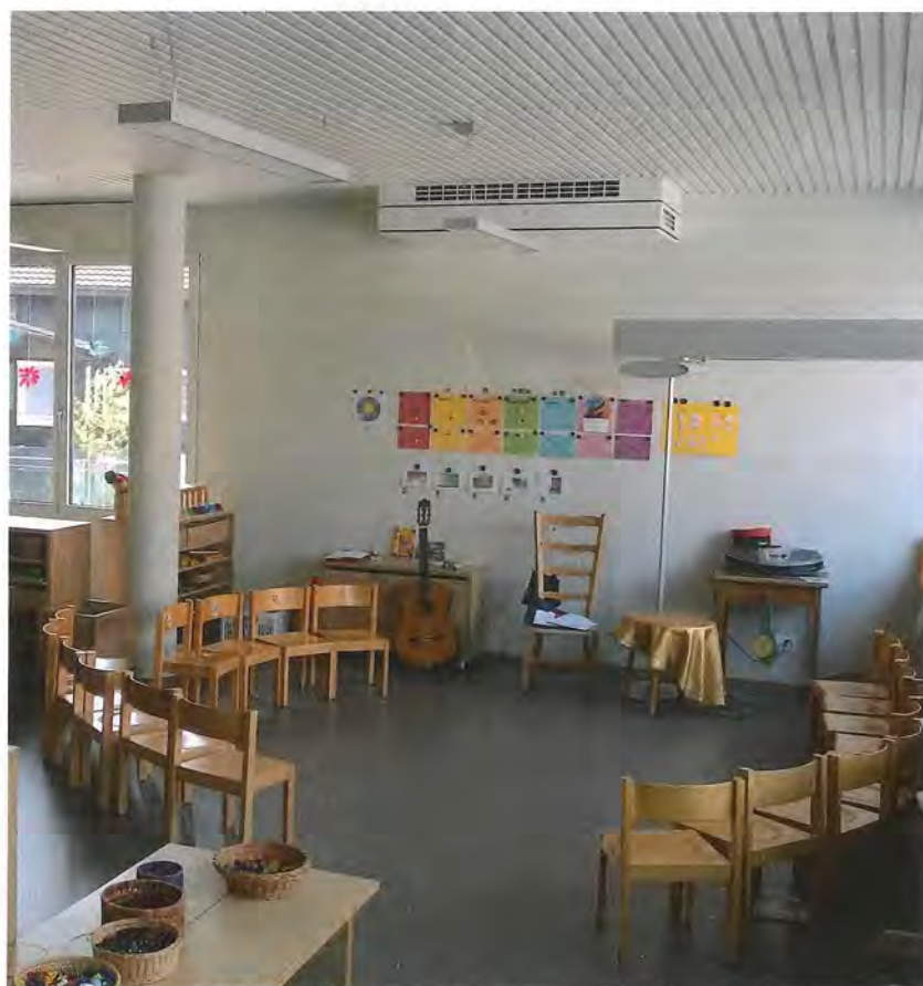
Kindergartenzimmer mit kompakter, dezentraler Lüftungsanlage Wesco Airmaster AM 500. (Foto: Wesco AG)
