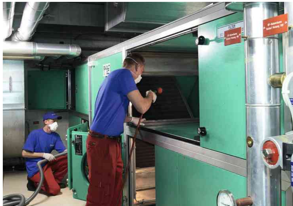
Verantwortung übernehmen: Während des Betriebs sind planmässige Wartungsarbeiten durchzuführen. (Foto: TOM-FM)
