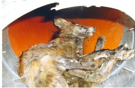
Pflanzen, Insekten und Kleintiere können sich in den Erdregisterrohren einnisten (z.B. durch ungesicherte und ebenerdige Ansaugstellen)
