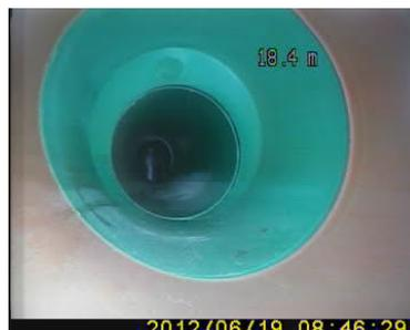
Beispiel mit einem mangelhaften Wanddurchlass, der einen reduzierten Querschnitt hat. Das Restwasser kann nicht ablaufen.
