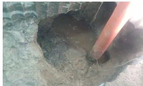
Beispiel: Teure Betonbohrungen durch eine 1 Meter dicke Bodenplatte.
