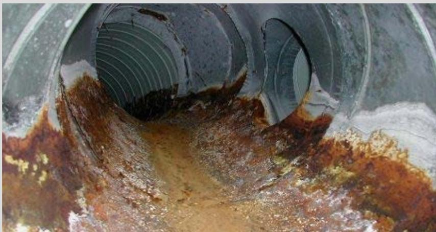
Korrosion und Bio-Filme durch Kondenswasser in Lüftungsanlagen
